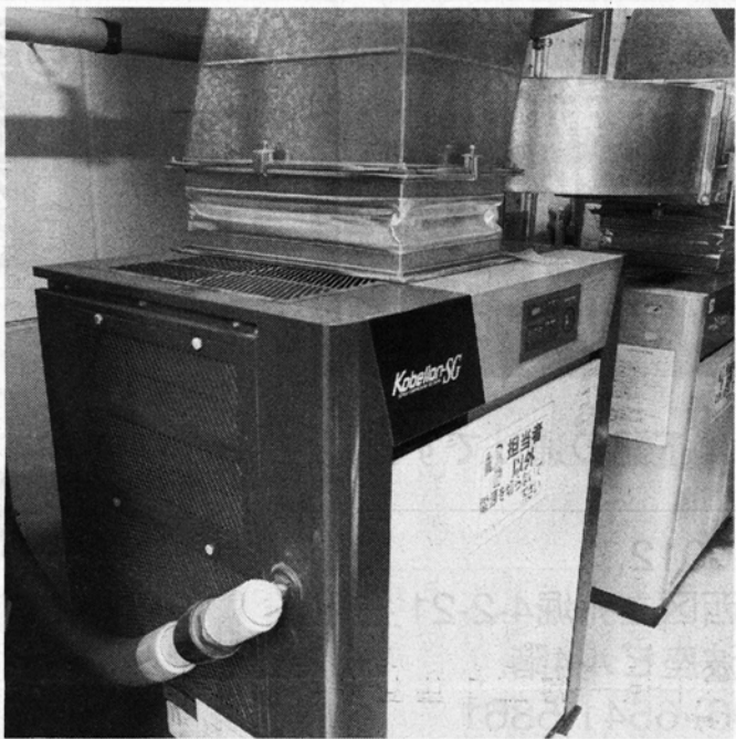
④空気圧縮機の2台目は補完的に利用 ⑤空気圧縮機の排熱も利用 ⑥張り巡らせた配管
